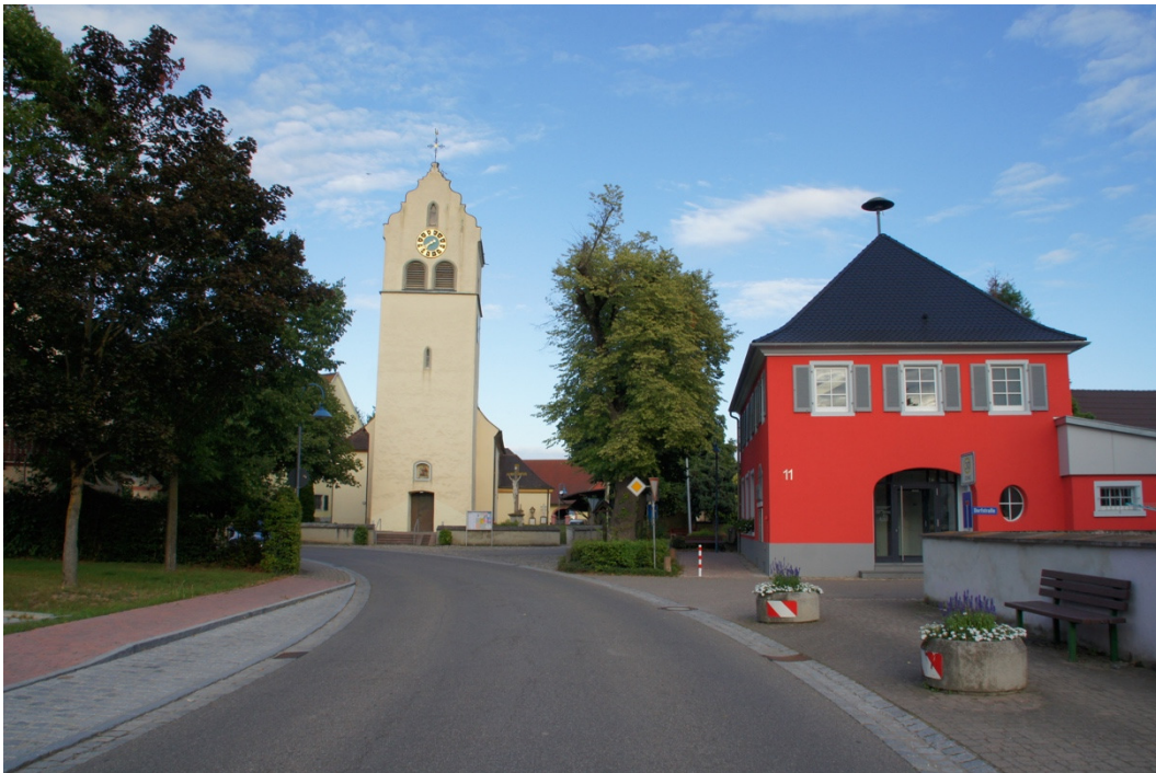
Abbildung 21: Sanierte Ortsverwaltung von Feldkirch
