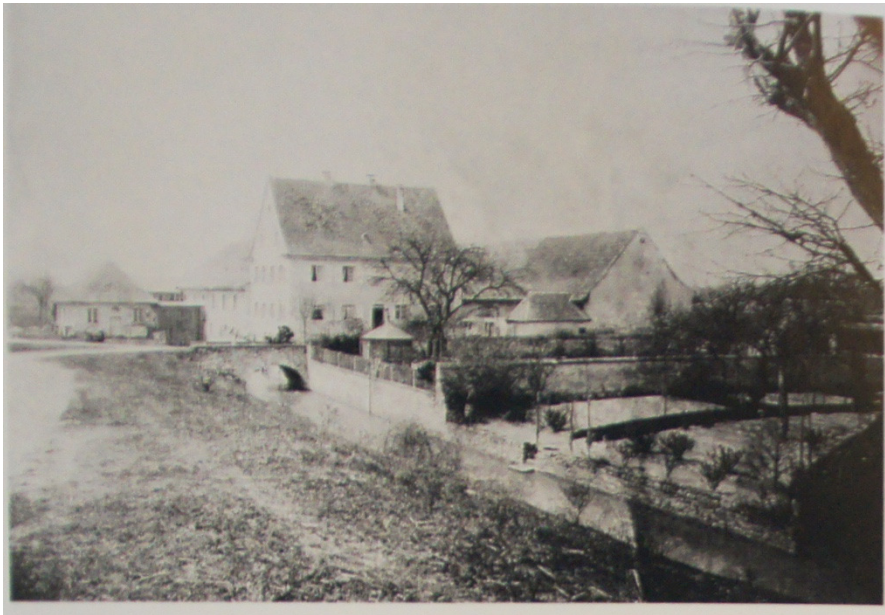
Abbildung 18: Alte Mühle in Hartheim 6
