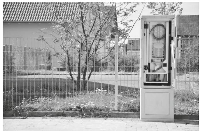
Röhrenverteiler für den Breitbandausbau in Feldkirch
